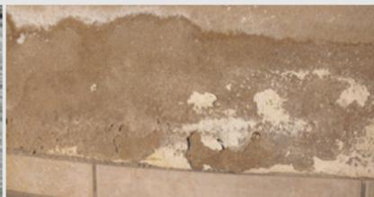
Nach und nach stieg die Feuchtigkeit durch die Kapillarkräfte des Mauerwerks nach oben.
