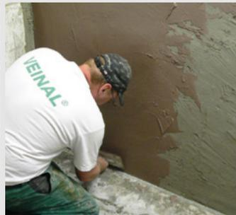
Anschließend wurde eine polymere Harzabdichtung aufgebracht.
